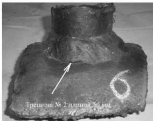
Рис. 5. Место образования трещины на сварном стыке приварки штуцера
